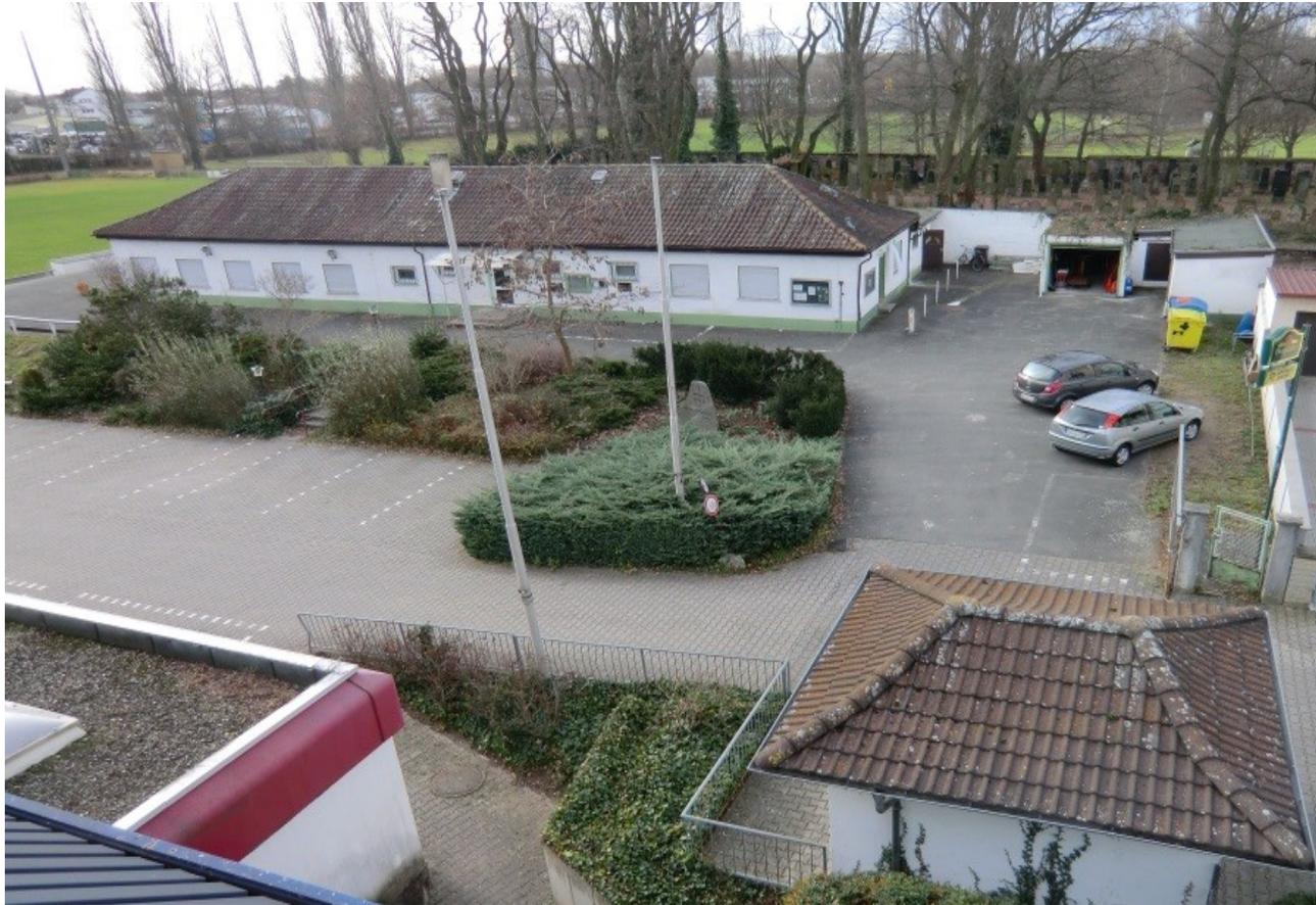
Das Vereinsheim aus den 50er Jahren ist vom Dach bis zum Keller in einem baukonstruktiv sehr schlechtem Zustand. Alle Außen- und Kellerwände zeigen aufsteigende Feuchtigkeit. Teilweise fällt der Innenputz von der Wand.
